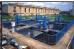
上下水処理場
