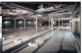
大規模立体駐車場
