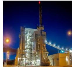
BFBボイラ 発電プラント
