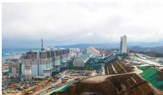
世界初石炭バイオマス混焼 550MW 超々臨界CFBボイラ (韓国Samcheok 2015年稼働)
