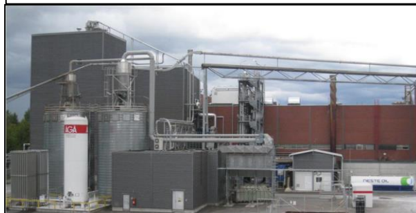
バイオマスでのデモプラント稼働中
