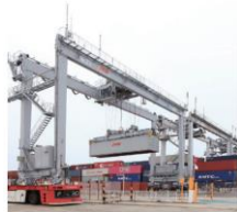
港湾クレーン
