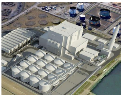
世界最大バイオマス専焼 300MW級 CFBボイラ (イギリスTeesside 2022年稼働予定)
