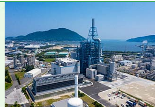
CFBボイラ発電プラント
