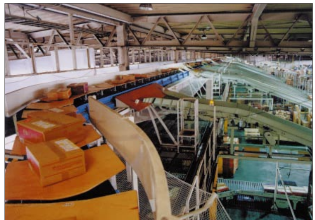
ロジスティクス&パーキングシステム事業部
