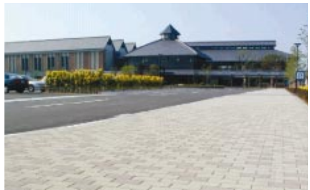
図6 インターロッキングブロック使用例（愛媛県紙産業研究センター 四国中央市） Illustration of blocks
