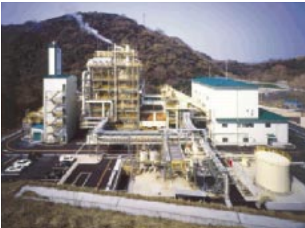
図4 エコニクス（財団法人愛媛県廃棄物処理センター） Industrial and municipal melting treatment system
