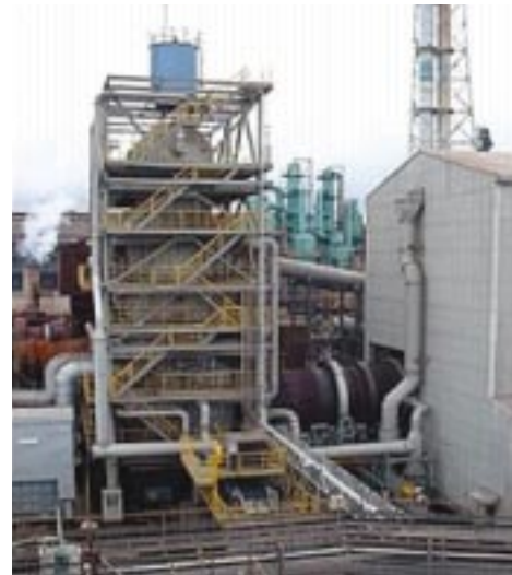
図2 産業廃棄物焼却設備（光和精鉱株式会社） Industrial waste treatment system
