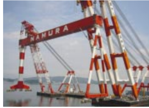
図5 既設ゴライアスクレーンの移設工事 Removal of existing goliath crane
