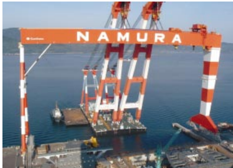
ゴライアスクレーンの据付け工事 Installation of goliath crane
