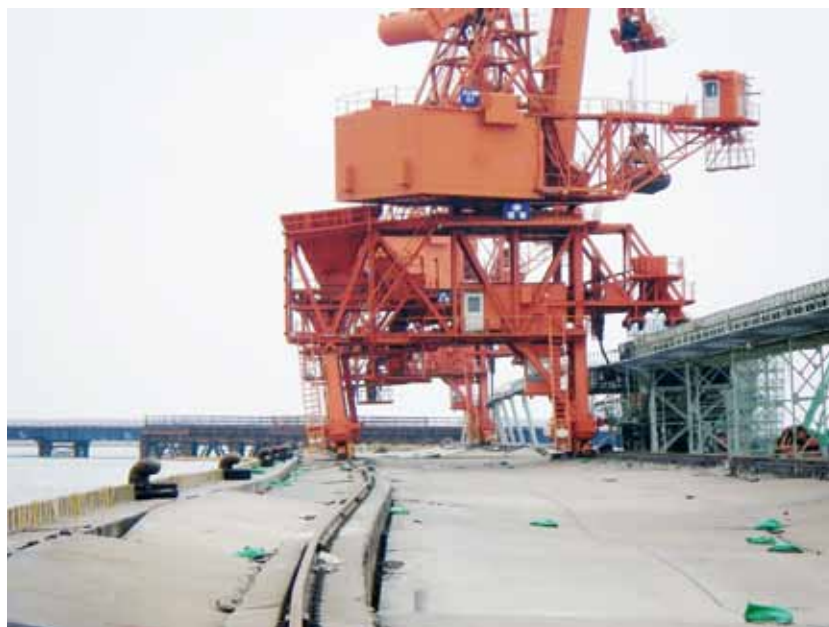
図1 クレーンの震災被害 Crane damage by earthquake disaster
