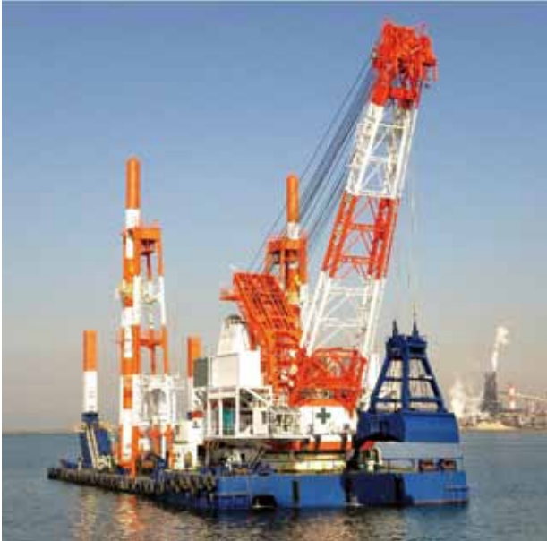
浚渫機 Grab bucket dredger
