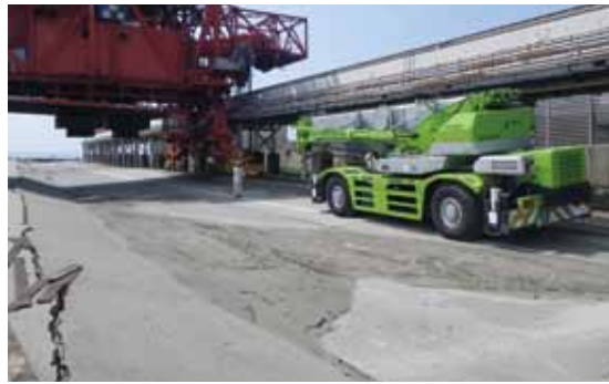
図11 クレーン牽引 Traction of crane
