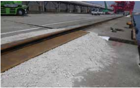
図10 仮設レール Makeshift rail
