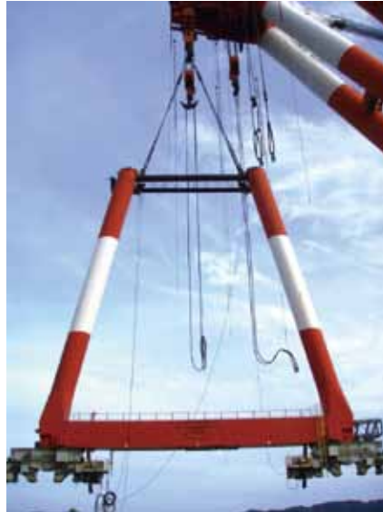
図8 脚下部ブロックの吊上げ Lift of a work of hinged leg
