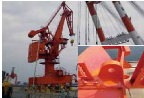
図9 吊りピース取付け、海上クレーンによる移設 Welded hanger, removed by a floating crane
