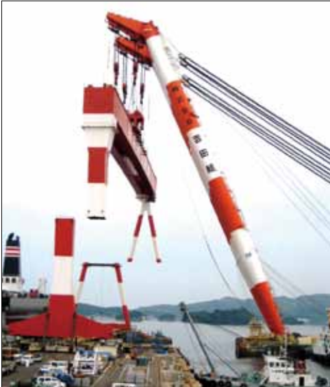
図7 クレーンの解体作業 Dismantling of existing crane
